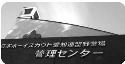
リフレッシュした管理棟
